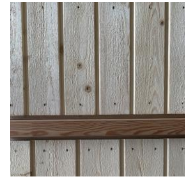
Fassadenverkleidung mit vertikaler Schalung aus Fichtenholz mit Nut und Kamm
