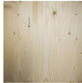
Dachuntersicht in den Dachwohnungen mit Dreischichtplatten Fichte natur
